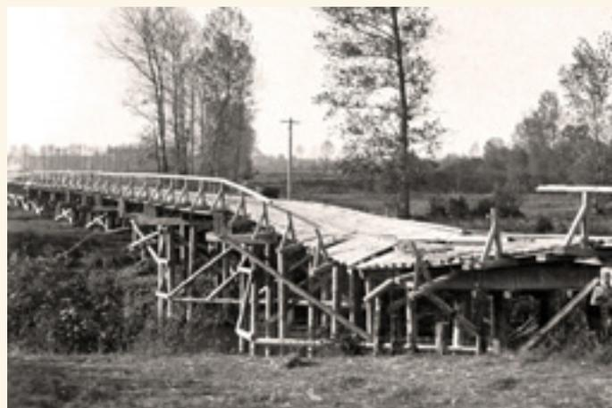
Entre Menneville et Pignicourt - La voie ferrée militaire allemande Guignicourt-Bazancourt franchissait l'Aisne et le canal au moyen d'une estacade d'environ 300 m. Endommagée en 1915 (photo), elle fut réparée puis détruite (vraisemblablement par incendie) lors de la retraite.
