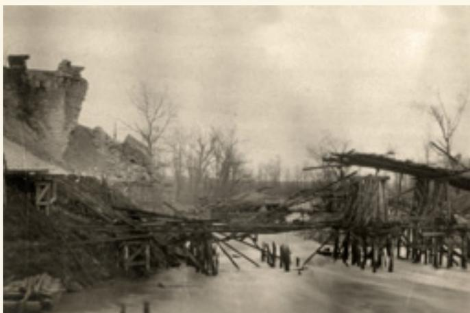
Guignicourt - Après la retraite des Allemands, voici les vestiges des 2 ponts de chemin de fer sur l'Aisne (culée du pont du chemin de fer de l'Est visible à gauche / tablier métallique du pont CBR au second plan).
